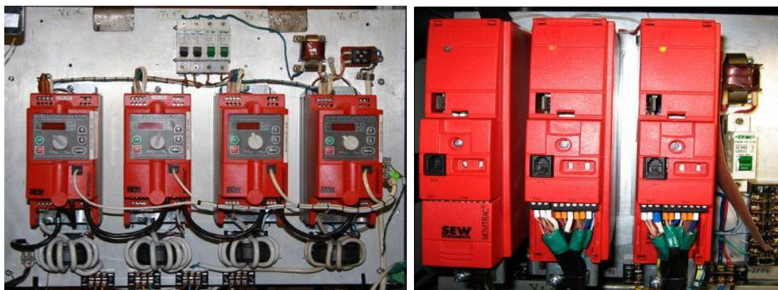
Рис. 23. Слева - щит частотных преобразователей для наведения и грубой коррекции, справа - частотные преобразователи для часового ведения и коррекции обеих осей телескопа.
