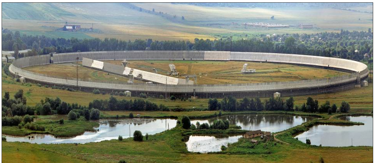
Рис. 3. Общий вид радиотелескопа с кольцевой антенной переменного профиля диаметром 600 метров РАТАН-600.
