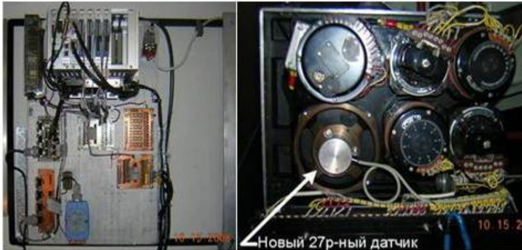
Рис. 14. Слева - контроллерный узел привода азимутальной оси, справа - отсчетный блок азимутальной оси.
